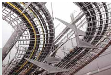
Cablofil wire mesh
